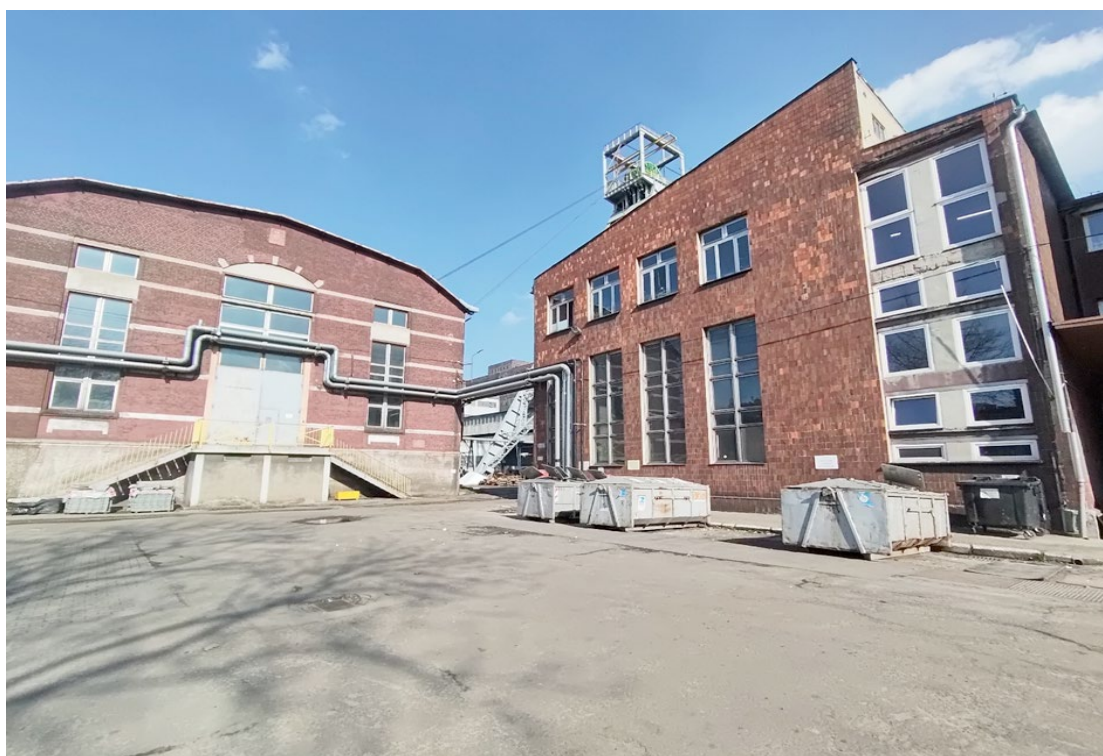
Fot. 1. Budynki należące do Kopalni Węgla Kamiennego Bobrek.
